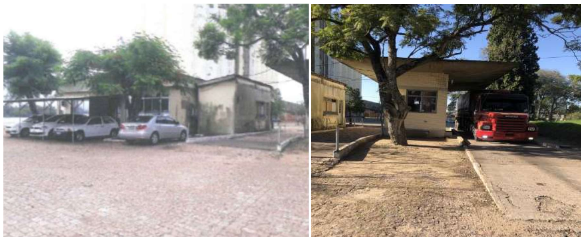
Figura 10: Prédio administrativo e balança rodoviária na área POA01 Fonte: SUPRG
